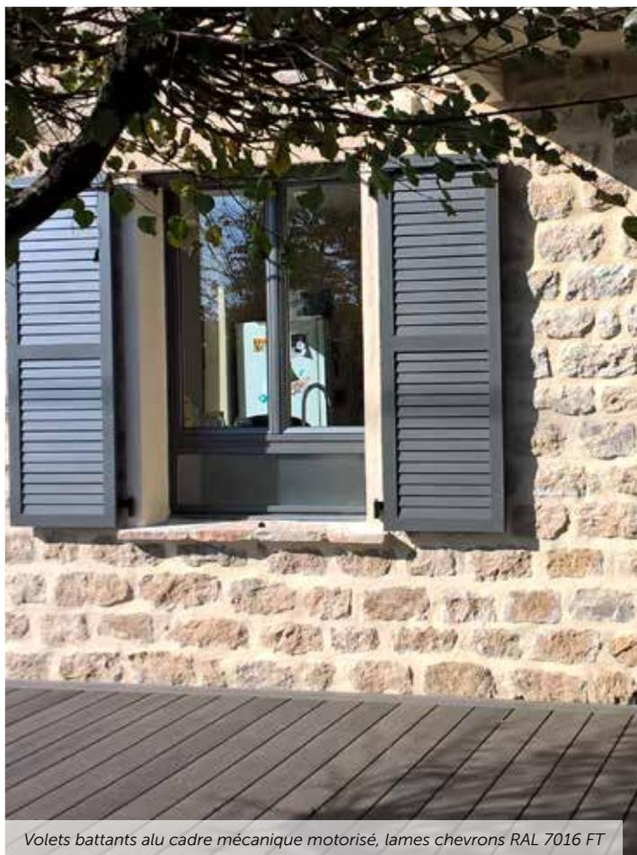
Volets battants alu cadre mécanique motorisé, lames chevrons RAL 7016 FT
